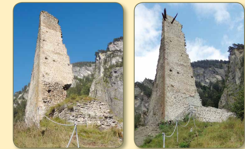
Vorzustand 2010 und gesicherter Turmrest 2012.
