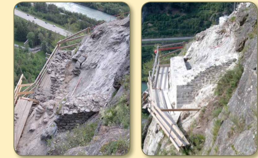
Südostpalas nach der Grabung und vor dem Ausgerüsten.
