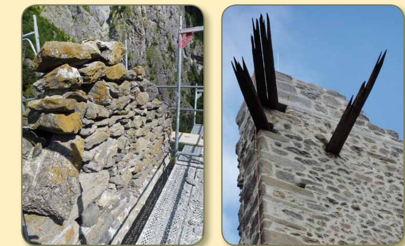
Vorzustand und gesicherte Turmkrone mit ergänzten Kragbalken.
