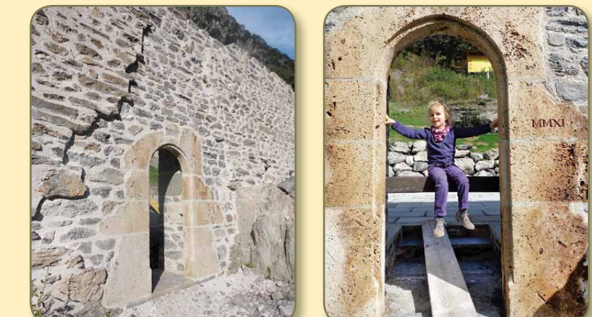
Rheintörlein: Vorzustand, Aufbau, Schattenfuge zum Sichtbarhalten der Ergänzung, Datierung.
