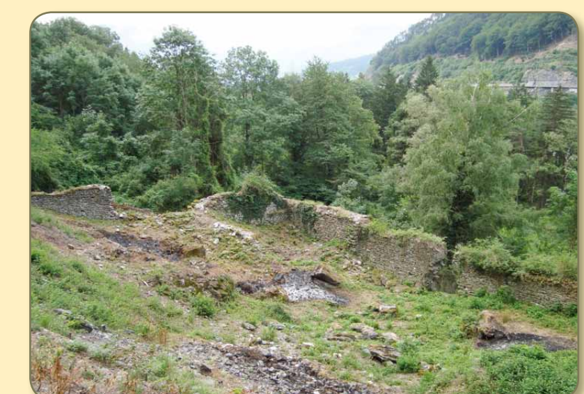
Südturm von Norden, Vorzustand 2010 nach dem Ausholzen.
