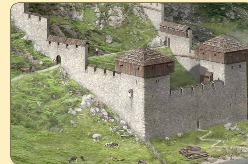
Das symmetrische Baukonzept sieht bei Baubeginn zwei gleichartige Ecktürme vor.
