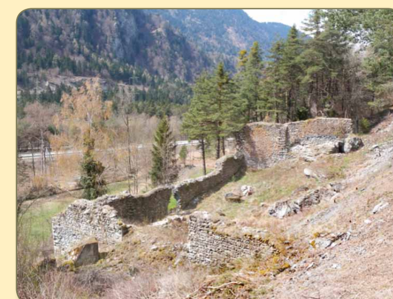
Talsperre von Osten. Vorzustand ausgeholt im April 2010. Die Übermauerung des Rheintörleins ist 1995, das Mauerwerk über der Bresche im Vordergrund schon vor dem 2. Weltkrieg eingestürzt.
