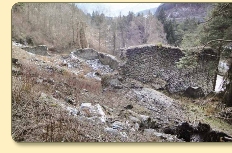
Nordfront Vorzustand 2010 nach dem Ausholzen.
