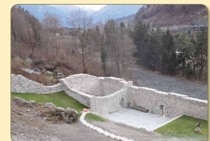
Südturm statisch gesichert mit neuer Nordfront und Nordecke.
