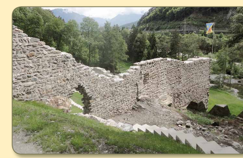
Nordfront 2012 gesichert und ergänzt. Die Mauerergänzung stützt die alten Mauern und lässt den Gesamtzusammenhang erkennen.
