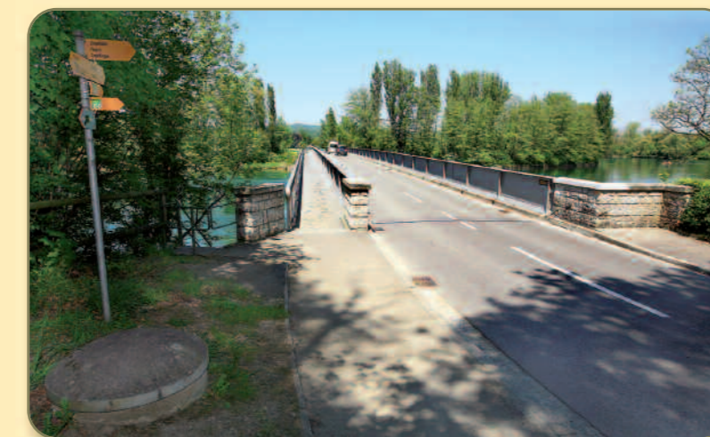
Rüdlinger Brücke Was am linken Bildrand wie der Deckel einer Brunnensäule aussieht, ist der Zündmineurschacht ZMS für die Sprengung der Rüdlinger Brücke. Dahinter der Einstieg für die Mineure zu den Zündverbindungen und Leitungen unter der Brücke, mit denen bei einem Angriff Wäpeler und Pfeiler gesprengt werden waren.
