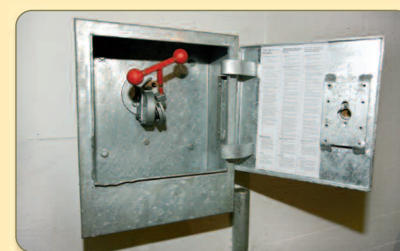
Zündkasten Als Sicherheit gibt es neben dem Zündmineurschacht im Kampfraum des Infanteriewerkes «Rüdlingen Brücke» einen gut gesicherten Kasten, zu dem nur der Bunkerkommandant einen Schlüssel hatte. Mit der Fernzündstelle konnte durch Drahtzug die Zündkette für die Brückensprengung ausgelöst werden.
