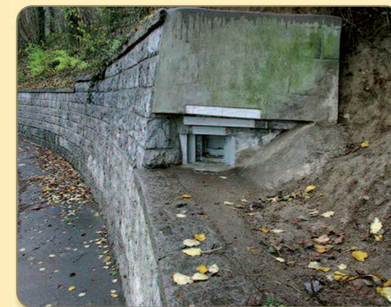
Leichtstand A 5440 Der Leichtstand A 5440 der Brückenverteidigung ist nur an der kleinen Scharte erkennbar, am Betondeckel darüber sind leichte Reste der Tarnmauer einer Quadernauer erhalten.
