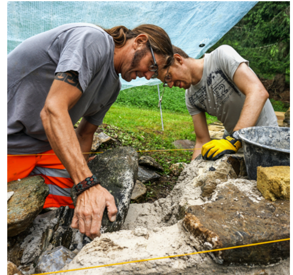
Christoph Hégéle drückt den Stein auf dem Mörtelbett in seine Idealposition. Er sollte seinen äussersten Punkt in die gewünschte Ebene geben, also etwa zwei Millimeter Abstand zur Schnur aufweisen.
