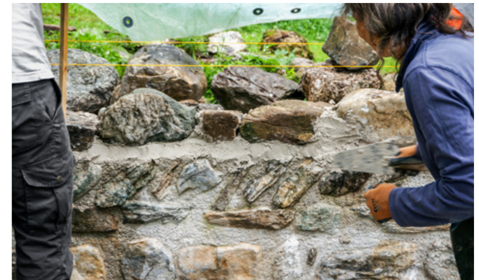
Alle Steine der Mauerschicht sind gesetzt. Leta Büechi hat die Fuge ausgeworfen und streicht diese noch glatt. Am nächsten Tag wird sie dann abschliessend gekratzt und gebürstet.
